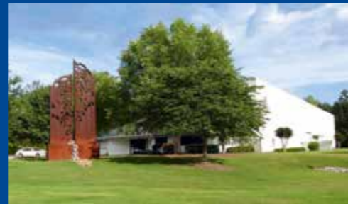
RAS Systems LLC à Georgia, USA
